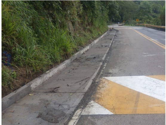
Foto 68: Reconstrucción de cuneta PR24+475 AL PR24+560
