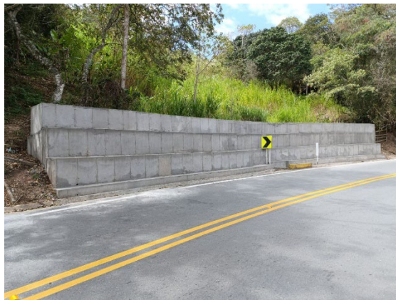
Foto 73: Recubrimiento de muro gavión PR34+620
