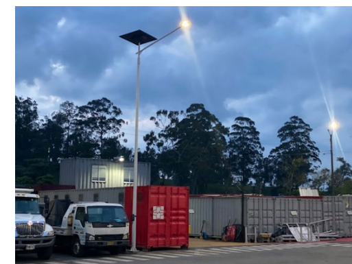
Foto 91: Instalación paneles solares iluminación CCO.
