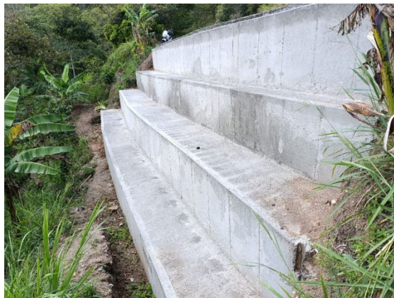
Foto 74: Recubrimiento de muro gavión PR34+756
