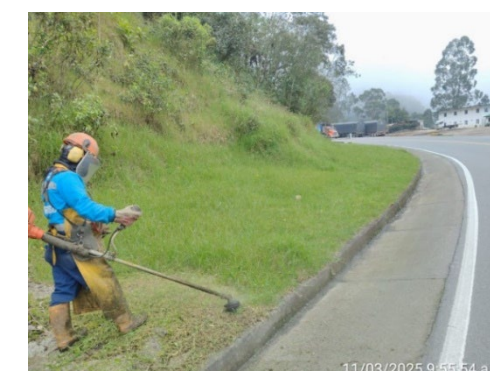
Foto 4: Rocería y desmonte PR96+350
