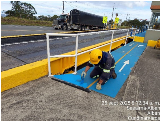
Foto 119: Pintura de plataformas.
