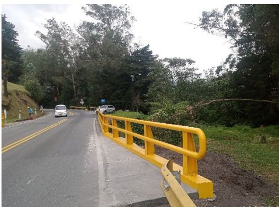
Foto 31: Mantenimiento correctivo Baranda Puente Niña María PR93+601
