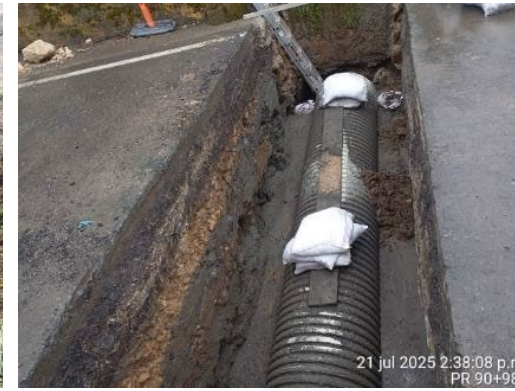
Foto 46: Reconstrucción de Alcantarilla 91+000
