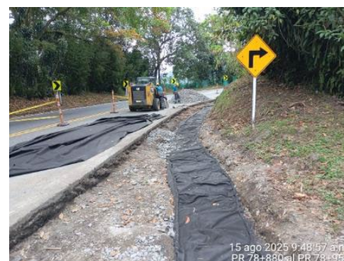
Foto 2: Reconstrucción de filtro PR78+830 - PR78+955
