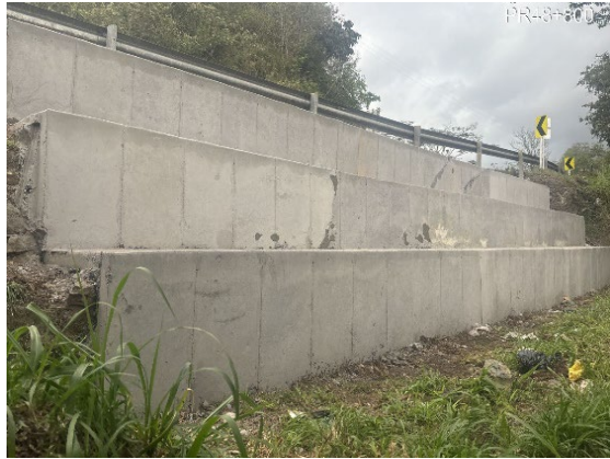
Foto 80: Recubrimiento de muro gavión PR48+784
