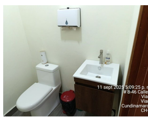
Foto 99: Remodelación baños Campamento de Viani.
