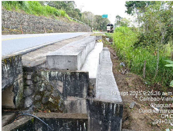
Foto 76: Recubrimiento de muro gavión PR39+024
