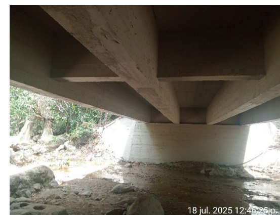
Foto 53: Mantenimiento Puente PR04+510
