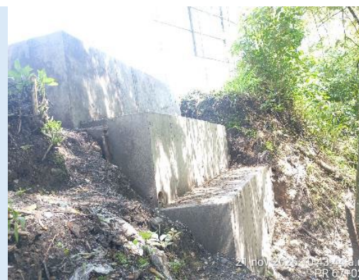
Foto 48: Revestimiento muro gavión PR 67+020
