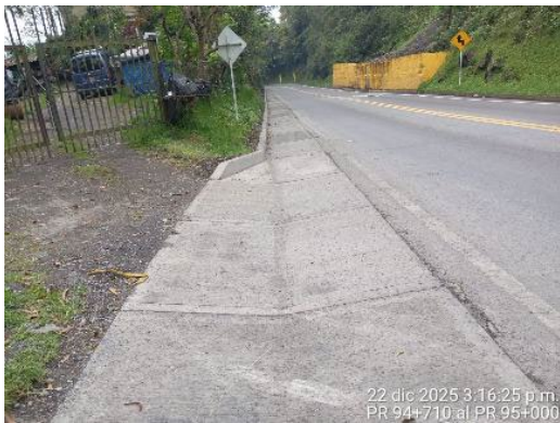
Foto 43: Reconstrucción de cuneta PR 94+710 al PR 95+000
