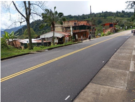
Foto 29: Mantenimiento carpeta asfáltica (Slurry) PR13+300 al PR71+434
