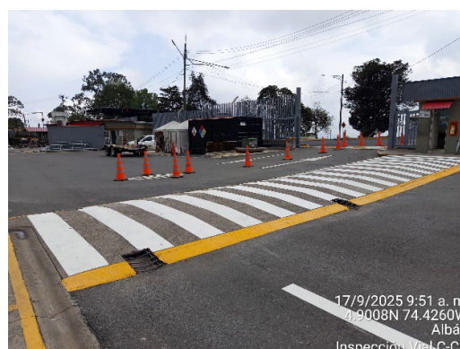
Foto 92: Mantenimiento señalización peatonal y parqueaderos CCO.
