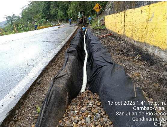
Foto 62: Reconstrucción de filtro PR24+213-PR24+335
