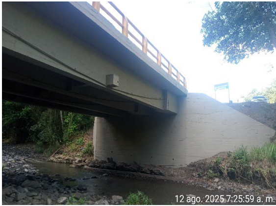
Foto 55: Protección puente PR56+356
