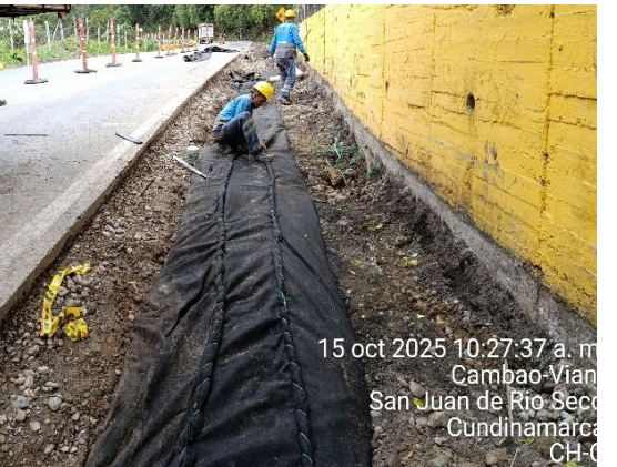
Foto 63: Reconstrucción de filtro PR24+213-PR24+335
