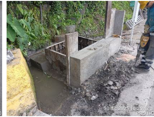
Foto 47: Reconstrucción de Alcantarilla 91+000
