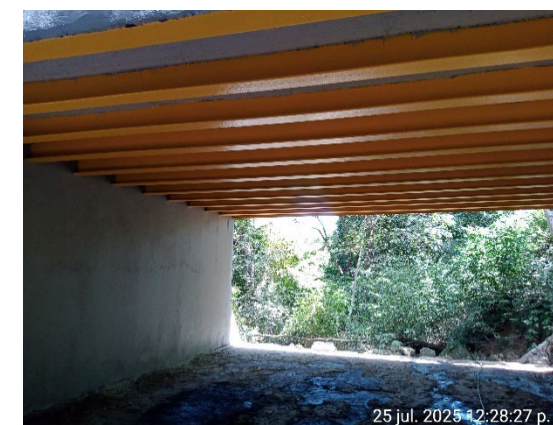
Foto 54: Protección Puente PR 15+890
