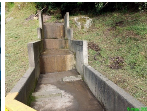
Foto 12: Limpieza de obras hidráulicas
