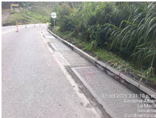
Foto 37: Reconstrucción de cuneta PR 78+080 al PR 78+180
