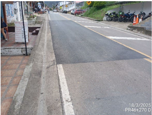
Foto 27: Mantenimiento carpeta asfáltica PR0+187 al PR74+380
