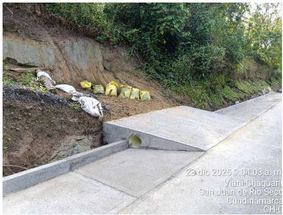
Foto 65: Reconstrucción cuneta PR 40+630 AL PR 40+820
