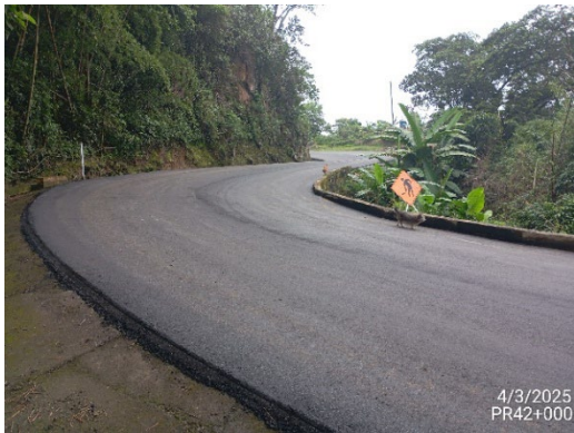
Foto 26: Mantenimiento carpeta asfáltica PR0+187 al PR74+380
