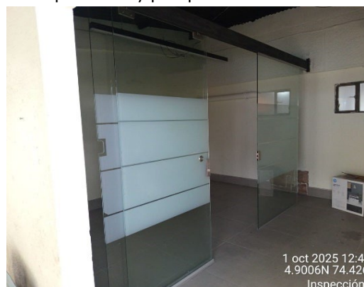
Foto 97: Adecuación nueva oficina equipos y vehículos.
