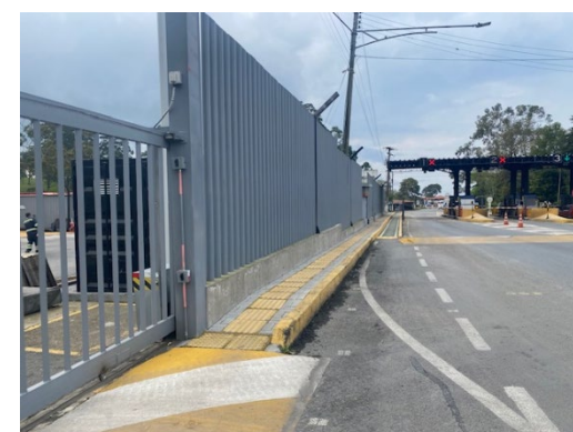
Foto 95: Instalación losas piso táctiles para sendero peatonal CCO.
