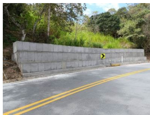
Foto 1: Recubrimiento de muro gavión PR34+620
