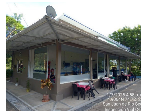
Foto 130: Actividades de mantenimiento (pintura) en el área de descanso Jalisco.
