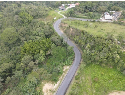
Foto 28: Mantenimiento carpeta asfáltica PR0+187 al PR74+380
