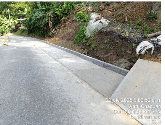
Foto 66: Reconstrucción de cuneta PR 40+630 AL PR 40+820
