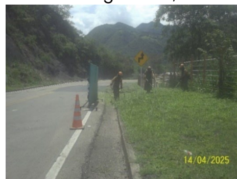
Foto 13: Rocería y desmonte PR 0+000 al PR 74+380
