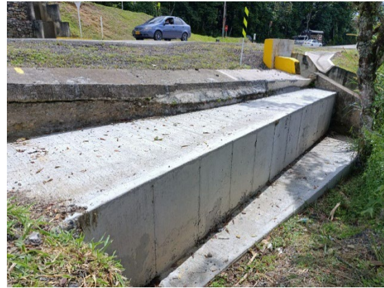
Foto 78: Recubrimiento de muro gavión PR39+089
