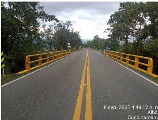
Foto 6: Mantenimiento general Puente PR 73+864
