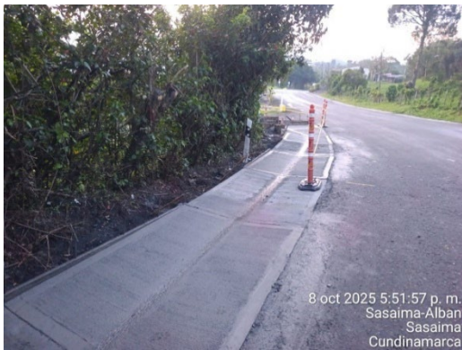
Foto 42: Reconstrucción de cuneta PR 84+050 al PR 84+115
