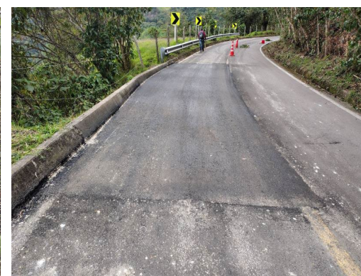
Foto 20: Mantenimiento carpeta asfáltica tramo vial Los Alpes – Quipile.
