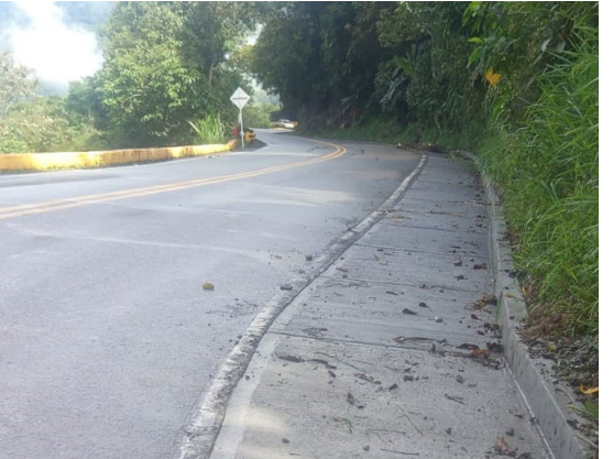
Foto 69: Reconstrucción de cuneta PR24+475 AL PR24+560
