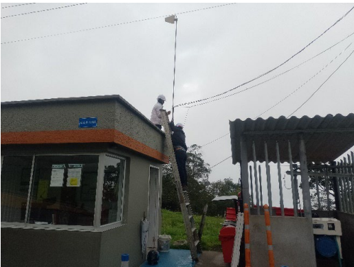
Foto 120: Instalación antena GSM.
