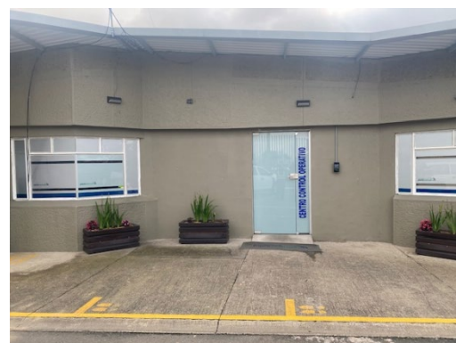
Foto 89: Adecuación entrada principal oficinas CCO.
