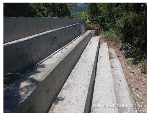
Foto 49: Revestimiento muro gavión PR 67+930
