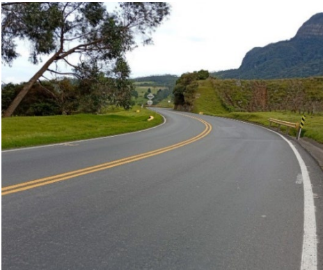
Foto 22: Mantenimiento Carpeta Asfáltica PR68+500 al 95+000
