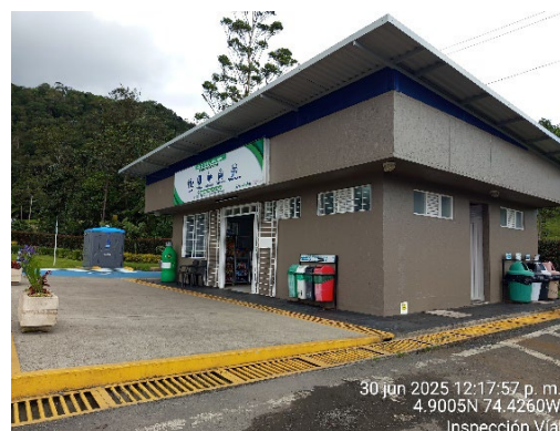
Foto 127: Actividades de mantenimiento (pintura) en el área de descanso Jalisco.
