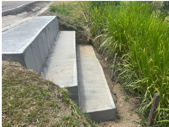
Foto 77: Recubrimiento de muro gavión PR39+050
