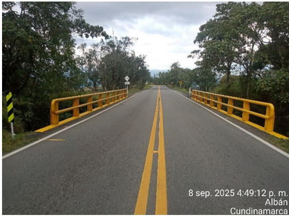
Foto 57: Renovación de Baranda Puente PR73+864
