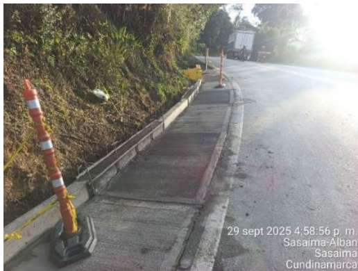
Foto 40: Reconstrucción de cuneta PR 83+050 al PR 83+120
