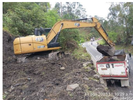
Foto 10: Remoción de derrumbes PR 94+950
