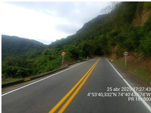
Foto 5: Demarcación vial PR16+500
