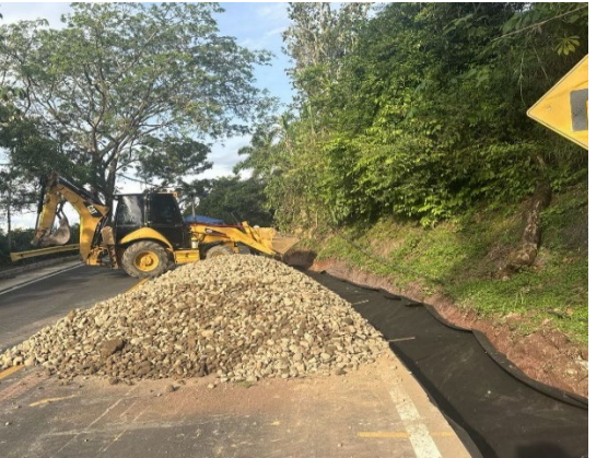
Foto 60: Reconstrucción de filtro PR23+000-R23+040
