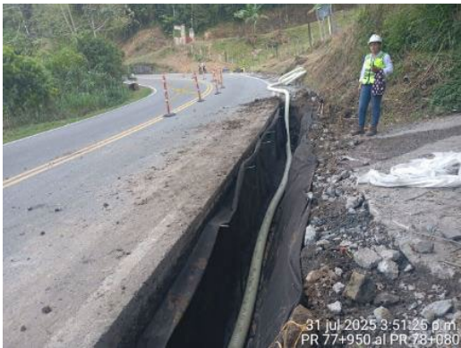
Foto 33: Reconstrucción de filtro PR 77+950 al PR 78+080
