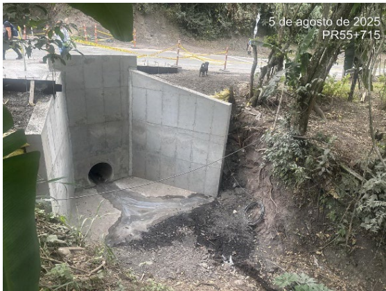
Foto 70: Reconstrucción de Alcantarilla 59+233
