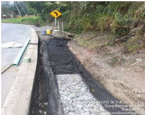
Foto 35: Reconstrucción de filtro PR 83+050 al PR 83+120
