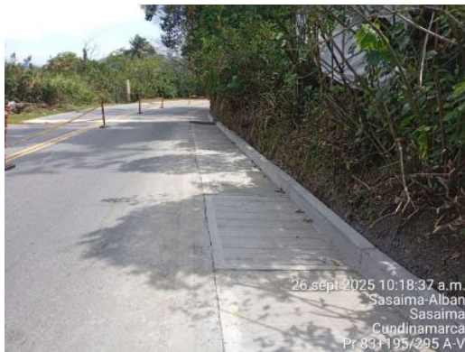
Foto 41: Reconstrucción de cuneta PR 83+195 al PR 83+295
