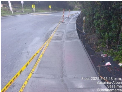
Foto 39: Reconstrucción de cuneta PR 84+050 al PR 84+115
