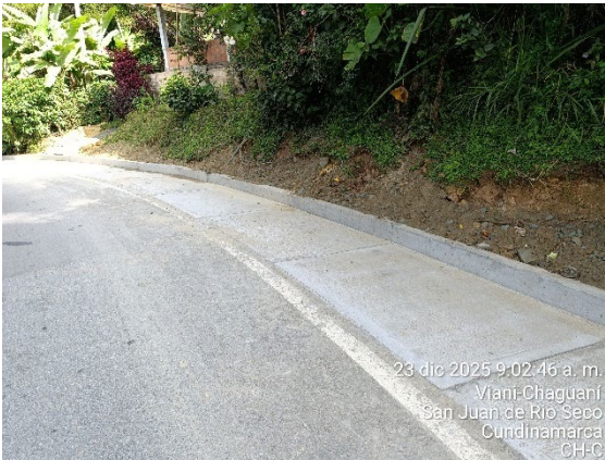
Foto 64: Reconstrucción cuneta PR 40+630 AL PR 40+820
