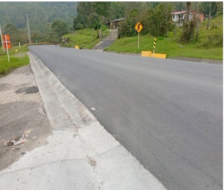
Foto 23: Mantenimiento Carpeta Asfáltica PR68+500 al 95+000
