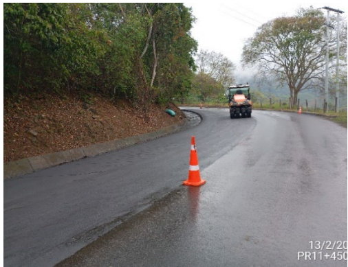
Foto 25: Mantenimiento carpeta asfáltica PR0+187 al PR74+380
