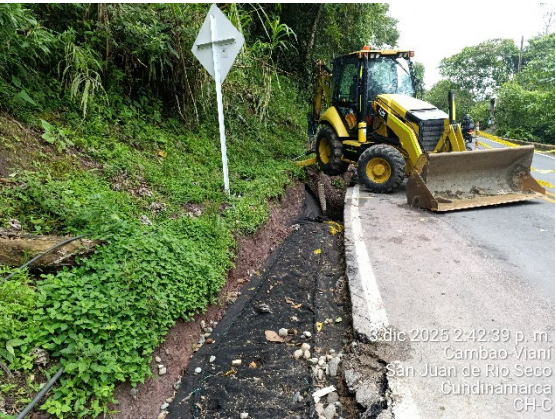
Foto 59: Reconstrucción de filtro PR22+990-PR23+090
