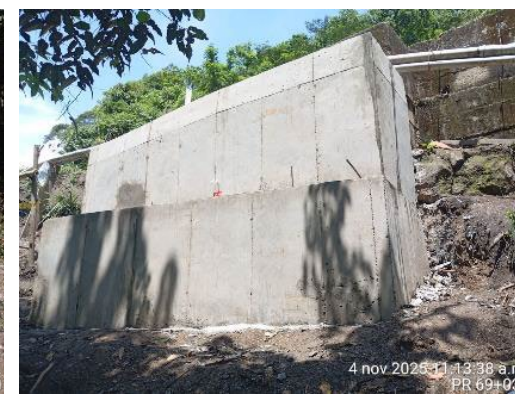
Foto 50: Revestimiento muro gavión PR 69+030
