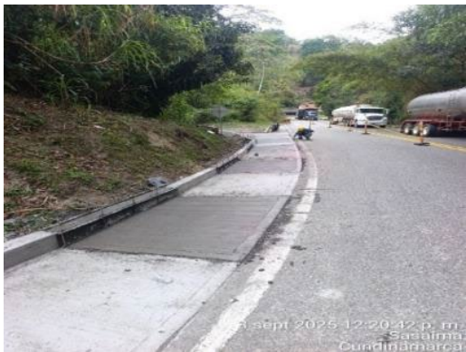
Foto 38: Reconstrucción de cuneta PR 78+830 al PR 78+955
