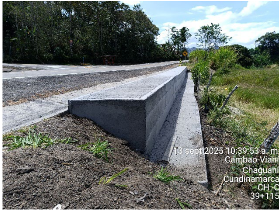
Foto 79: Recubrimiento de muro gavión PR39+115
