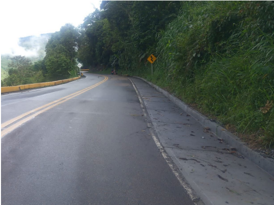
Foto 67: Reconstrucción de cuneta PR24+475 AL PR24+560
