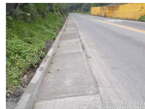
Foto 3: Reconstrucción cuneta PR 94+710 AL PR 95+000
