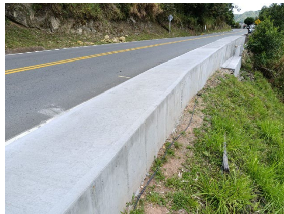
Foto 72: Recubrimiento de muro gavión PR34+224
