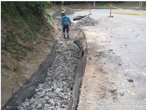
Foto 34: Reconstrucción de filtro PR 78+830 al PR 78+955
