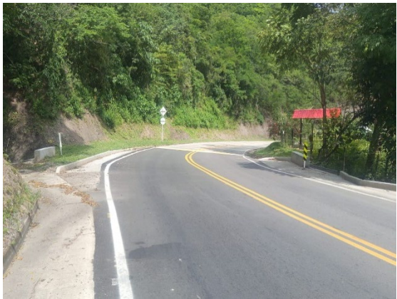
Foto 71: Reconstrucción de Alcantarilla 59+233
