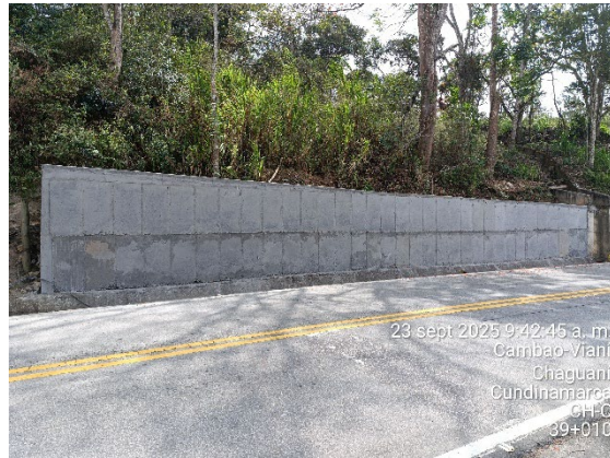
Foto 75: Recubrimiento de muro gavión PR39+004
