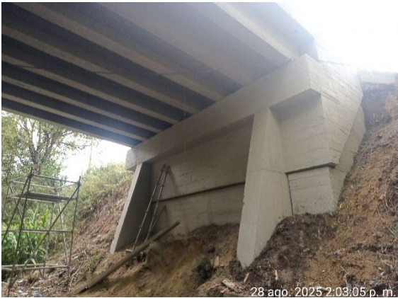
Foto 56: Protección Puente PR 73+864
