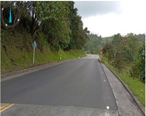
Foto 24: Mantenimiento Carpeta Asfáltica PR68+500 al 95+000
