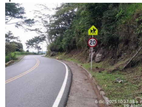
Foto 16: Reposición de señales verticales PR 40+057
