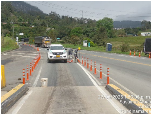
Foto 118: Reemplazo hitos carril de acceso.
