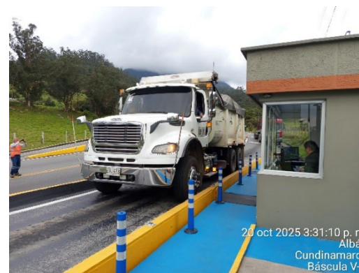
Foto 116: Verificación básculas por parte del OAVM.
