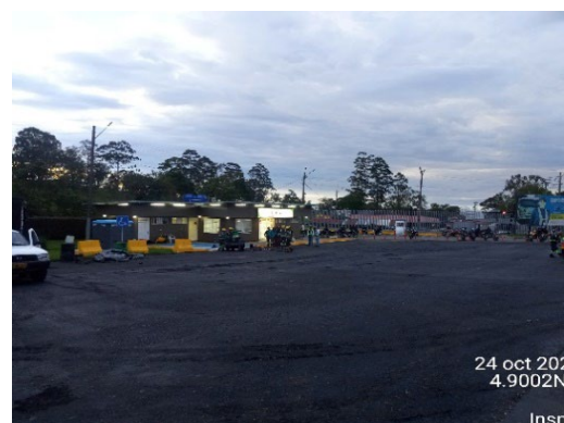
Foto 128: Renivelación parqueadero de área de descanso de Jalisco.
