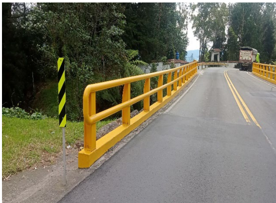
Foto 30: Mantenimiento correctivo Baranda Puente Niña María PR93+601
