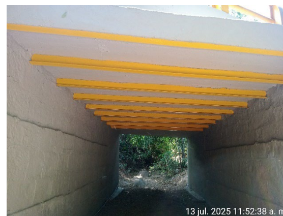
Foto 52: Mantenimiento Puente PR03+670
