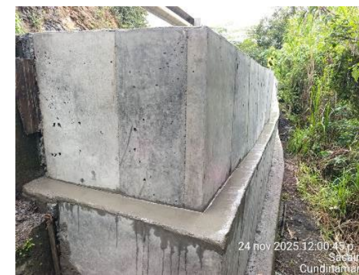
Foto 51: Revestimiento muro gavión PR 80+900
