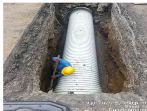
Foto 44: Reconstrucción de Alcantarilla 80+013
