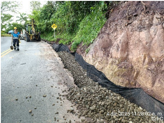
Foto 58: Reconstrucción de filtro PR22+990-PR23+090
