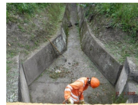
Foto 17: Limpieza de estructuras hidráulicas
