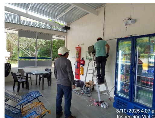
Foto 131: Labores de mantenimiento eléctrico área de descanso de Cambao.
