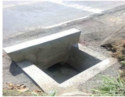
Foto 45: Reconstrucción de Alcantarilla 80+013
