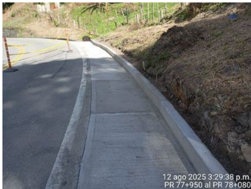
Foto 36: Reconstrucción de cuneta PR 77+950 al PR 78+080
