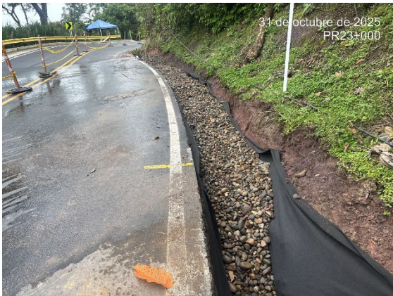
Foto 61: Reconstrucción de filtro PR23+000-R23+040
