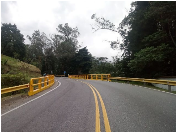
Foto 32: Mantenimiento correctivo Baranda Puente Niña María PR93+601
