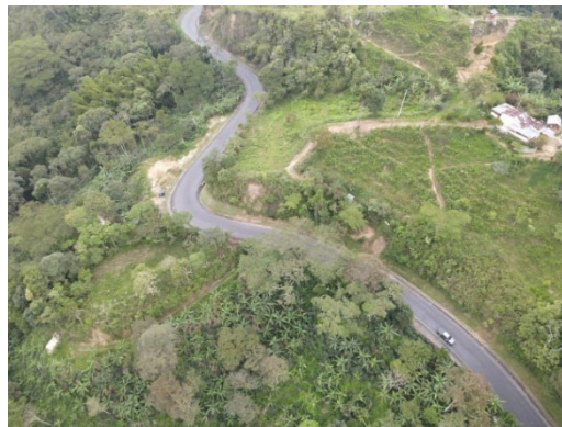
Foto 7: Mantenimiento carpeta asfáltica PR 51+400 al PR 74+000
