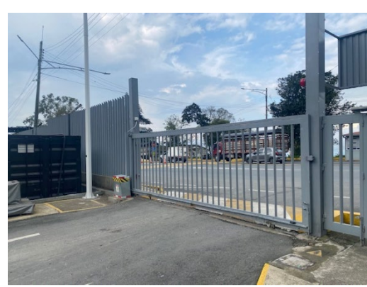
Foto 98: Instalación motor puerta acceso vehicular CCO.
