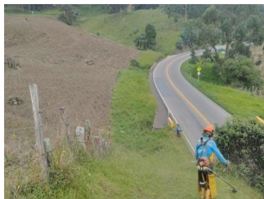
Foto 9: Rocería y desmonte PR 66+900 al PR 101+040
