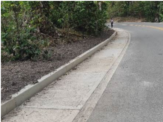
Foto 91: Reconstrucción cuneta PR 41+800 AL PR 41+870
