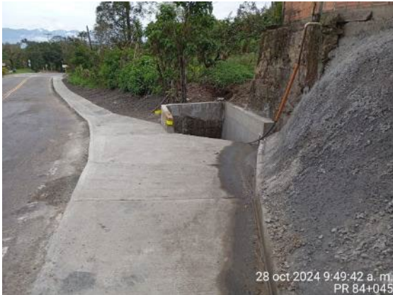
Foto 44: Reconstrucción de cuneta PR 83+962 al PR 84+045
