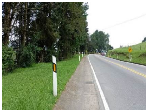
Foto 15: Reposición de hitos de arista PR 93+370
