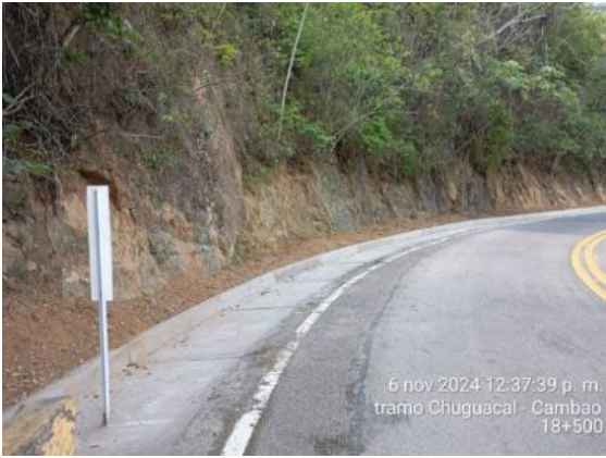
Foto 93: Reconstrucción de cuneta PR18+500 AL PR18+625
