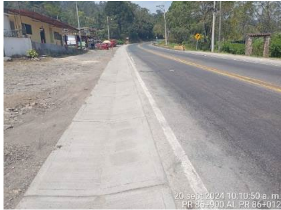
Foto 48: Reconstrucción de cuneta PR 85+890 al PR 86+012
