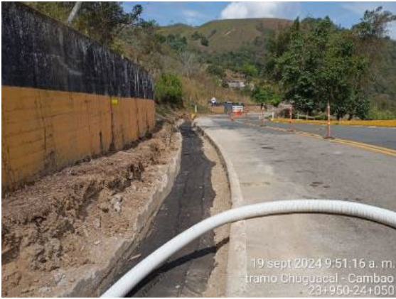
Foto 87: Construcción de filtro PR23+930 – R24+040
