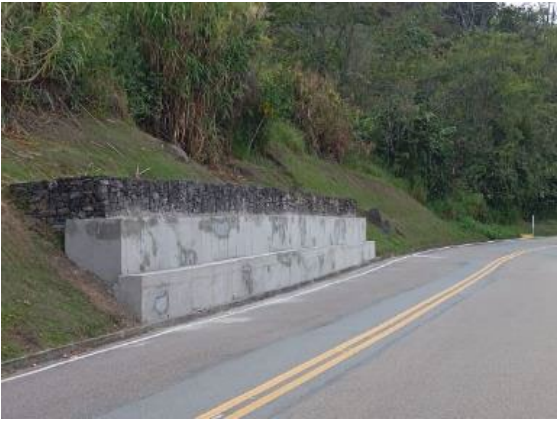
Foto 107: Recubrimiento de muro gavión PR48+720
