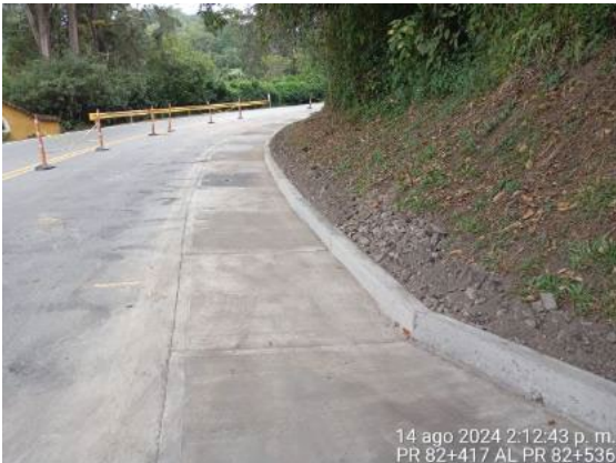
Foto 41: Reconstrucción de cuneta PR 82+417 al PR 82+535
