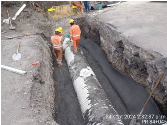
Foto 53: Reconstrucción de Alcantarilla 84+045
