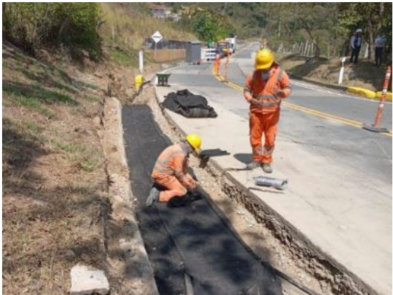
Foto 86: Construcción de filtro PR23+930 – R24+040
