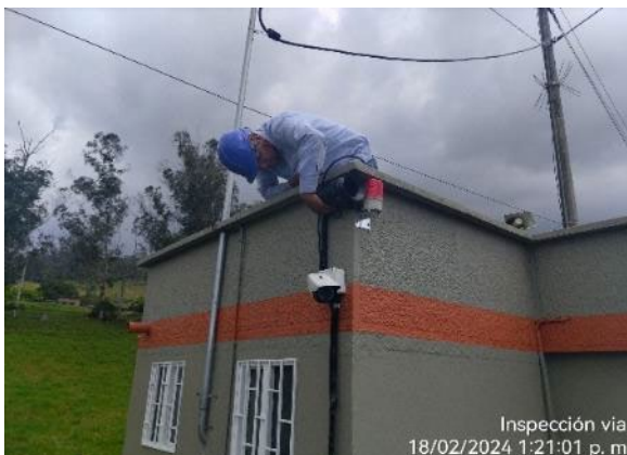
Foto 153: Trabajos de instalación de balizas y alarma en casetas de básculas.
