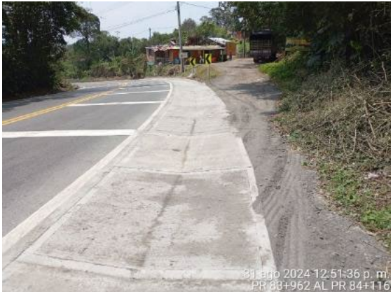
Foto 45: Reconstrucción de cuneta PR 84+045 al PR 84+116
