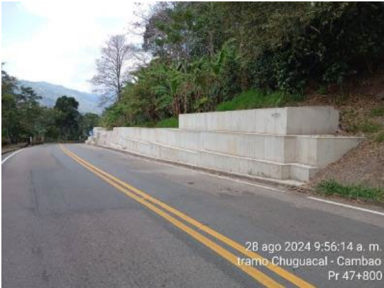
Foto 104: Recubrimiento de muro gavión PR47+800
