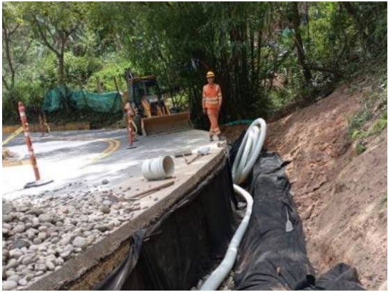
Foto 89: Construcción de filtro PR35+113 – PR35+178
