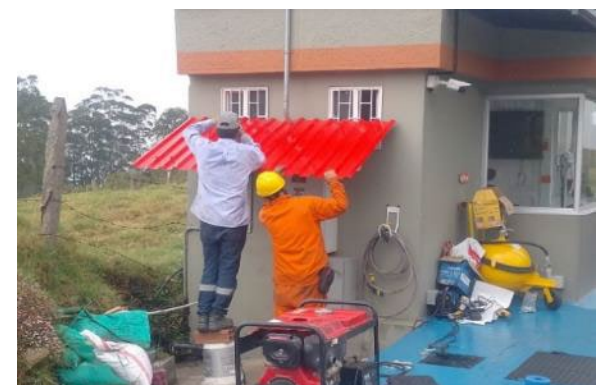
Foto 125: Instalación de cubiertas en oficinas de básculas
