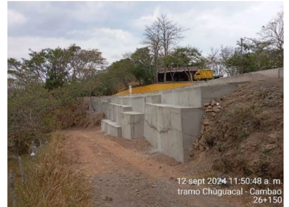
Foto 109: Recubrimiento de muro gavión PR26+110
