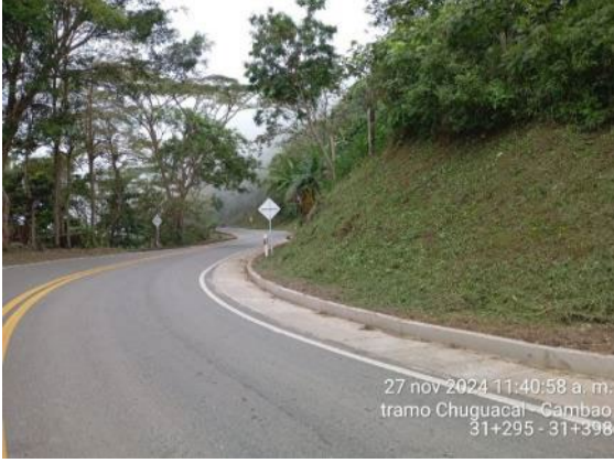
Foto 96: Reconstrucción cuneta PR31+295 – PR31+398
