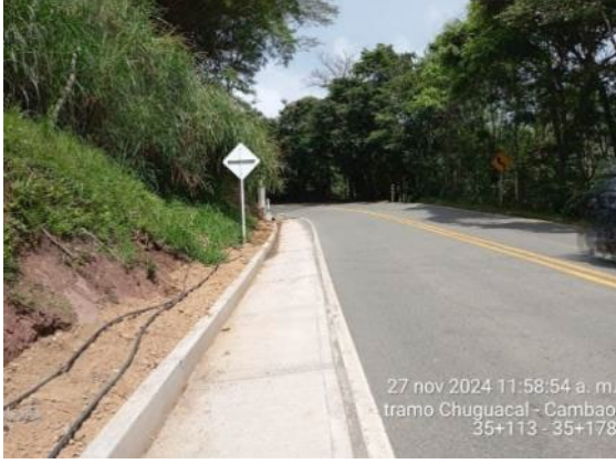
Foto 99: Reconstrucción de cunetas PR35+113 – PR35+178
