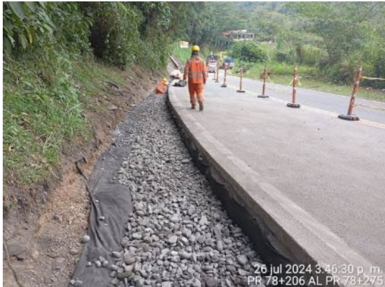
Foto 38: Reconstrucción de filtro PR 78+206 al PR 78+275
