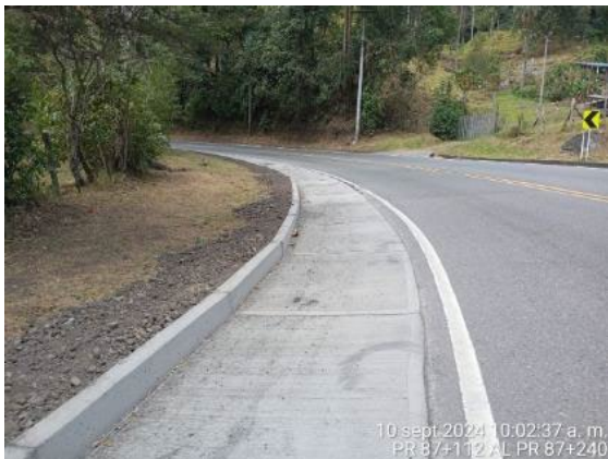
Foto 49: Reconstrucción de cuneta PR 87+112 al PR 87+240
