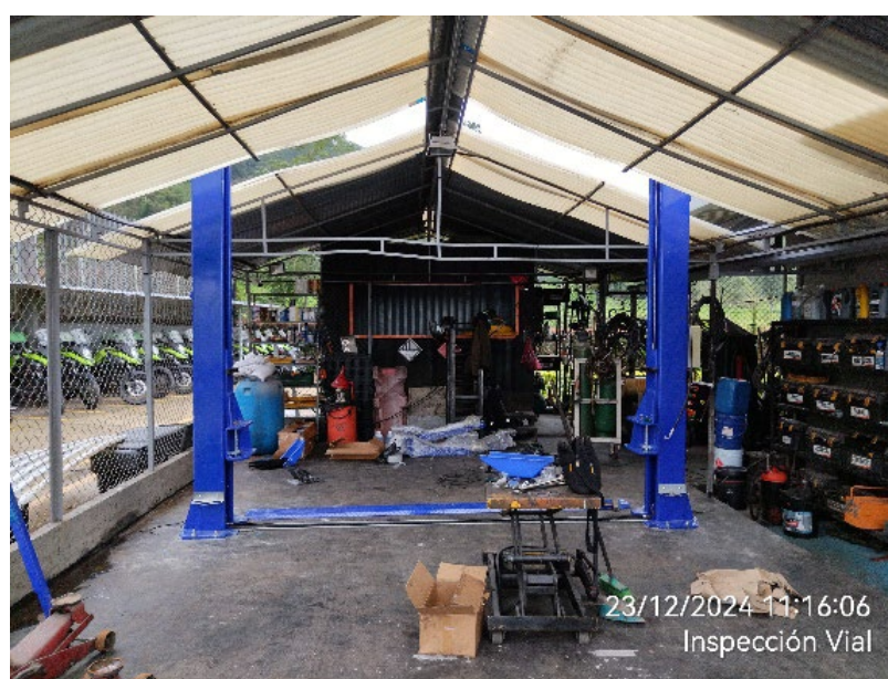
Foto 133: Adecuaciones para la instalación de elevador hidráulico en el taller.
