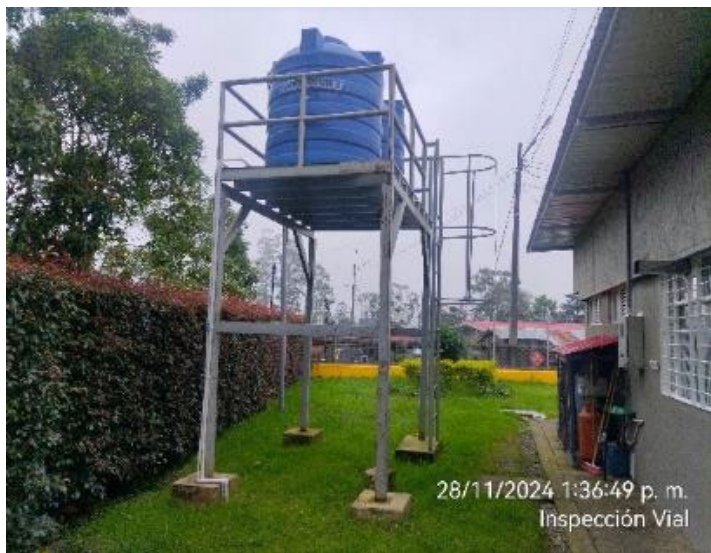
Foto 167: Instalación tanque de reserva
