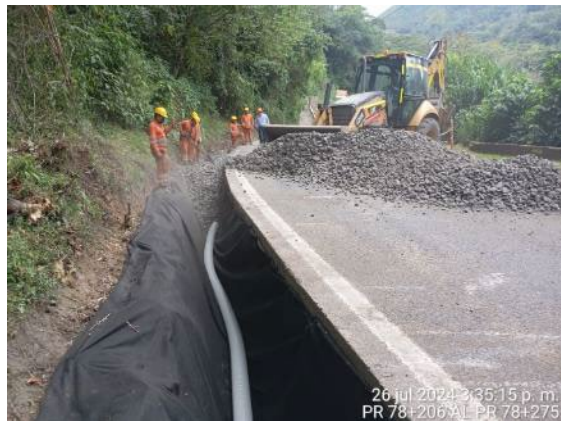
Foto 37: Reconstrucción de filtro PR 78+206 al PR 78+275
