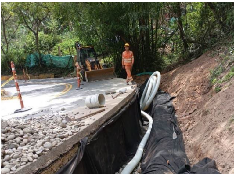
Foto 3: construcción de filtro PR35+113 – PR35+178
