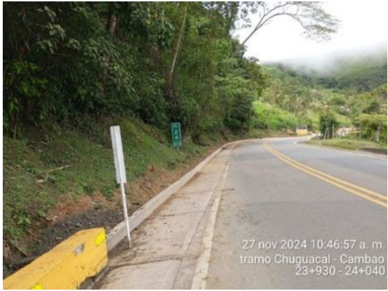
Foto 95: Reconstrucción de cunetas PR23+930 – R24+040
