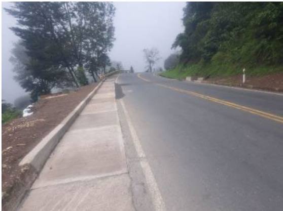
Foto 42: Reconstrucción de cuneta PR 90+160 al PR 90+190
