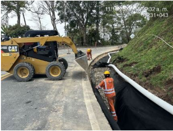
Foto 88: Construcción de filtro PR31+295 – PR31+398
