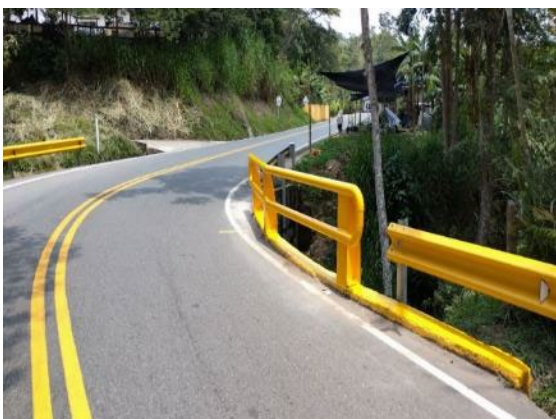
Foto 77: Instalación Baranda Tipo Invias PR 35+236
