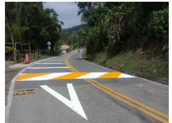
Foto 21: Demarcación horizontal en todo el tramo
