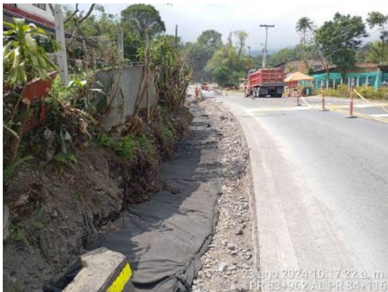
Foto 35: Reconstrucción de filtro PR 83+962 al PR 84+045
