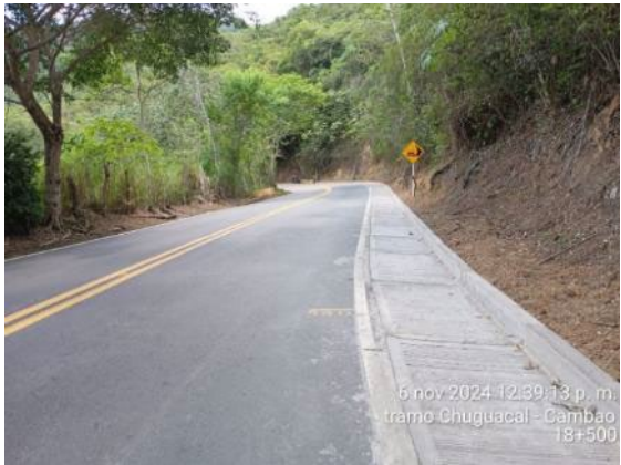
Foto 92: Reconstrucción de cuneta PR18+500 AL PR18+625
