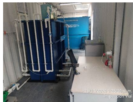
Foto 130: Instalación de planta de tratamiento de aguas residuales PTAR
