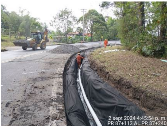
Foto 36: Reconstrucción de filtro PR 87+112 al PR 87+240
