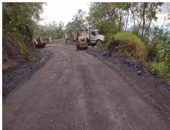
Foto 26: Renivelación con fresado cemento y emulsión Alpes – Quipile.
