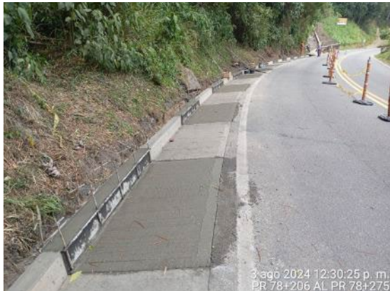
Foto 40: Reconstrucción de cuneta PR 78+206 al PR 78+275
