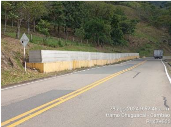
Foto 106: Recubrimiento de muro gavión PR47+490
