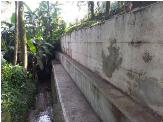
Foto 56: Revestimiento muro gavión PR 83+430
