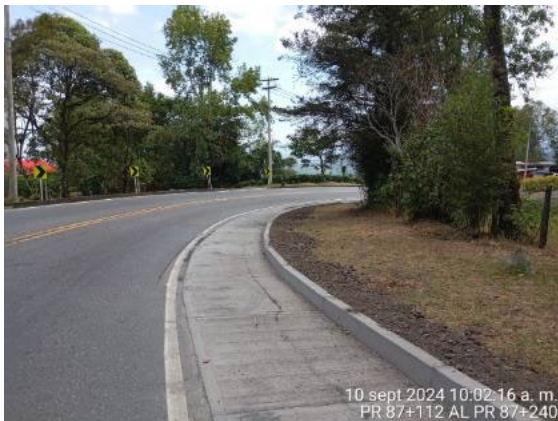
Foto 50: Reconstrucción de cuneta PR 87+112 al PR 87+240
