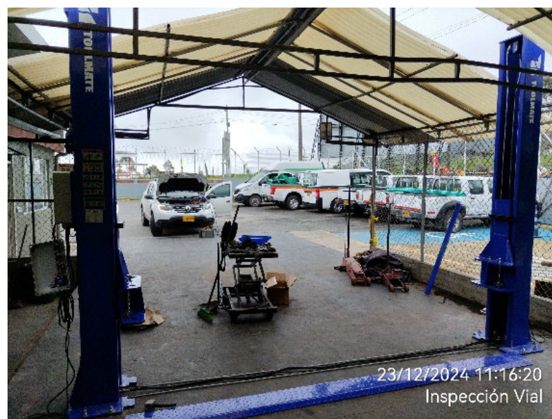
Foto 132: Adecuaciones para la instalación de elevador hidráulico en el taller.
