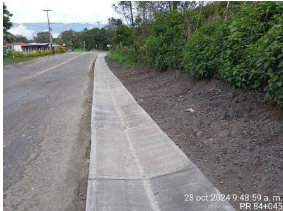
Foto 43: Reconstrucción de cuneta PR 83+962 al PR 84+045
