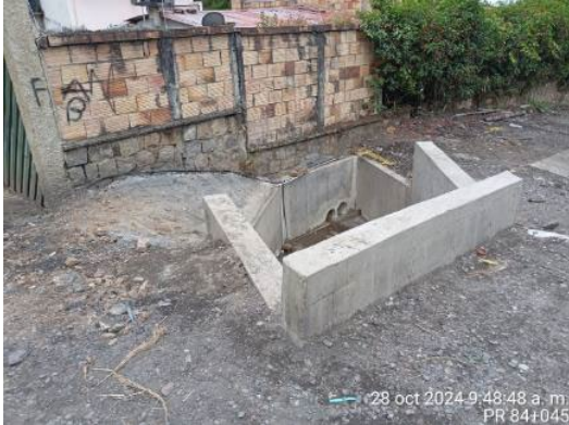
Foto 54: Reconstrucción de Alcantarilla 84+045
