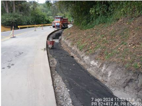
Foto 39: Reconstrucción de filtro PR 82+417 al PR 82+535
