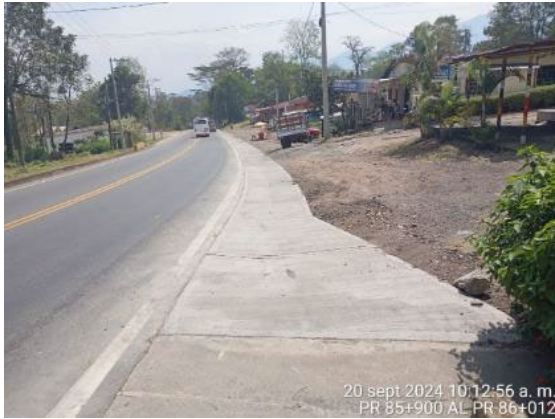
Foto 47: Reconstrucción de cuneta PR 85+890 al PR 86+012
