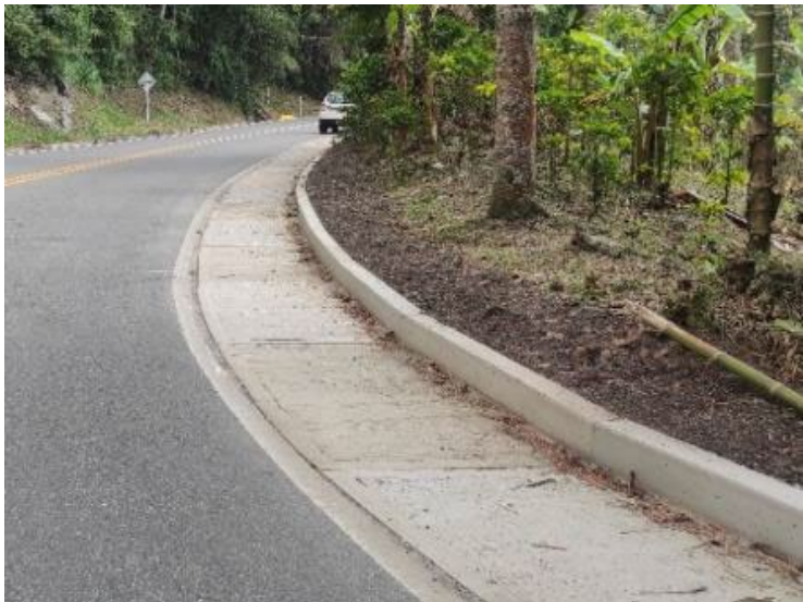
Foto 4: Reconstrucción cuneta PR 41+800 AL PR 41+870
