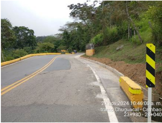
Foto 94: Reconstrucción de cunetas PR23+930 – R24+040
