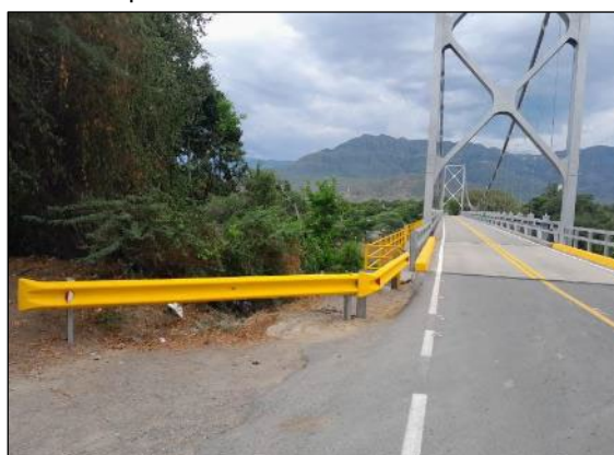
Foto 23: Reposición de defensas metálica PR 0+000
