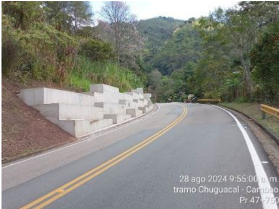
Foto 105: Recubrimiento de muro gavión PR47+740
