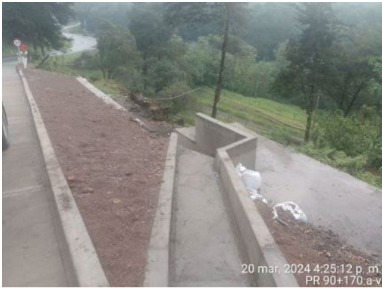
Foto 52: Reconstrucción de Alcantarilla 90+170
