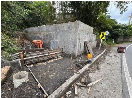
Foto 57: Revestimiento muro gavión PR 83+500
