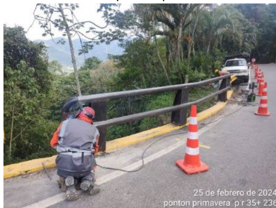
Foto 74: Instalación Baranda Tipo Invias PR35+236
