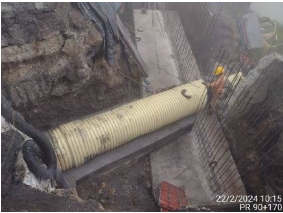
Foto 51: Reconstrucción de Alcantarilla 90+170
