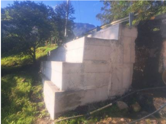
Foto 59: Revestimiento muro gavión PR 87+645
