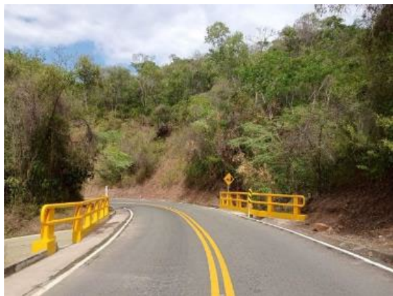
Foto 70: Instalación Baranda Tipo Invias PR6+188
