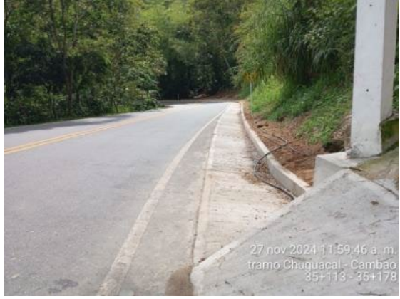
Foto 98: Reconstrucción de cunetas PR35+113 – PR35+178
