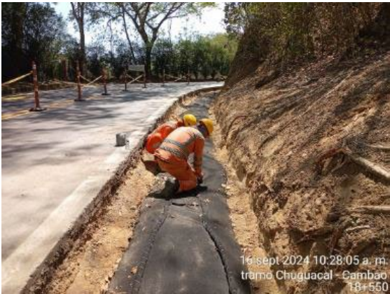
Foto 84: Construcción de filtro PR18+500 – PR18+625
