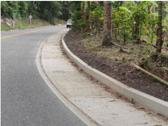
Foto 90: Reconstrucción cuneta PR 41+800 AL PR 41+870
