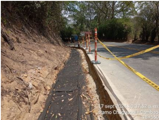
Foto 85: Construcción de filtro PR18+500 – PR18+625
