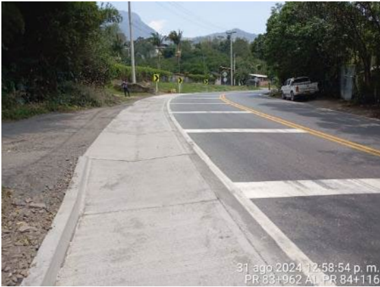
Foto 46: Reconstrucción de cuneta PR 84+045 al PR 84+116
