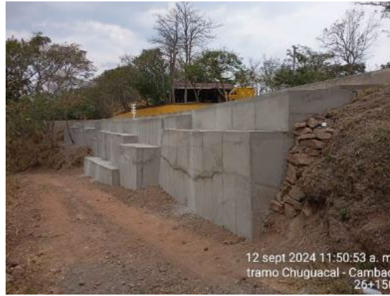
Foto 108: Recubrimiento de muro gavión PR26+110
