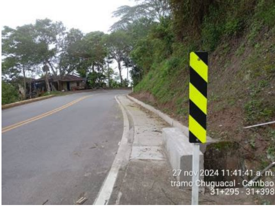
Foto 97: Reconstrucción cuneta PR31+295 – PR31+398
