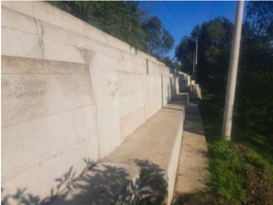
Foto 58: Revestimiento muro gavión PR 87+610
