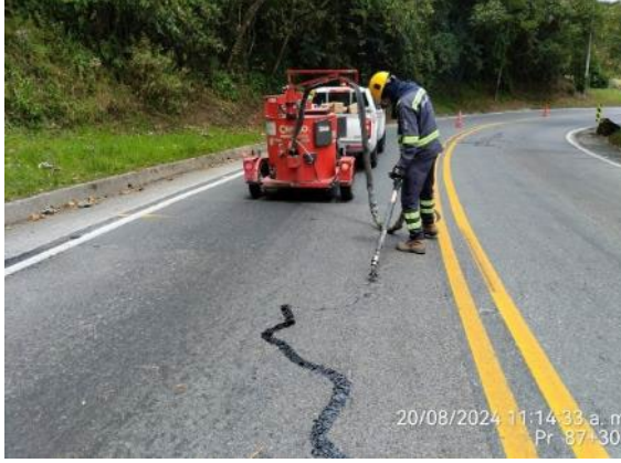
Foto 17: Sello fisuras PR 66+900 al PR 101+040
